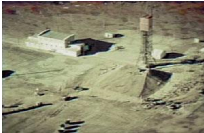
ระเบิด “แอตแลนตัส-6C” ถูกติดตั้งบนหอดูสูง 30 เมตร (ภาพก่อนการจุดระเบิด)
